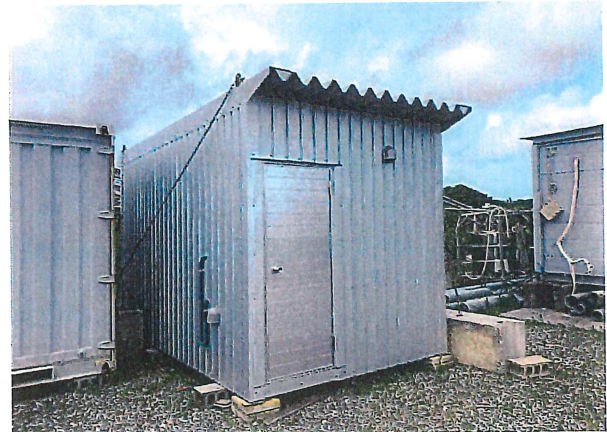
トイレ筐体外装
